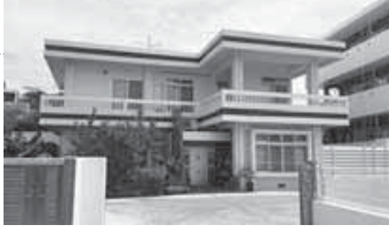
沖縄の台風に備えた鉄筋コンクリート造りの家
